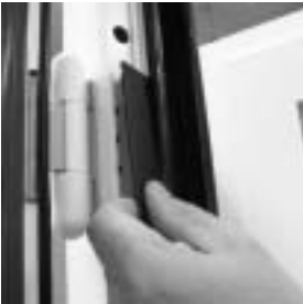
1. Kunststoffabdeckung entfernen.
