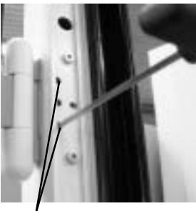
1. Beide Spannschrauben bis zum Anschlag lösen.
