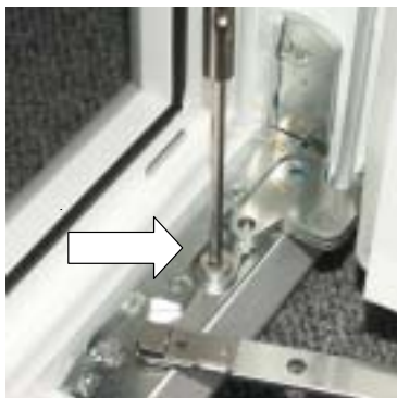
Verstellung Richtung Band- oder Getriebeseite mit Inbusschlüssel SW4.
