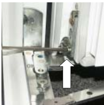
Anpressdruckverstellung mit Inbusschlüssel SW4.
