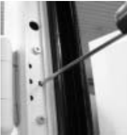
1. Kunststoffabdeckung entfernen.
