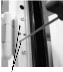
1. Beide Spannschrauben lösen.
