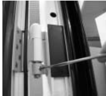
2. Fixierschraube lösen.
