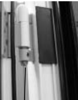
3. Höhenteller durch Drehung nach rechts bzw. links in gewünschte Position bringen.
