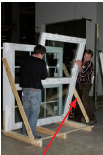
5. Diese schräge Strebe bleibt bis zum Schluss
