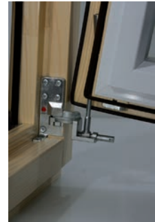
5. Flügel leicht anheben ca. 20 mm, dann neigen und herausziehen
