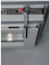
SICHERHEITS-PILZZAPFEN Flügelandruckeinstellung (SW 11) +/- 1 mm
