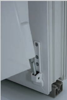
1. Flügel im unteren Ecklager einführen
