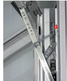
Flügelandruckeinstellung an der Schere oben +/- 1 mm
