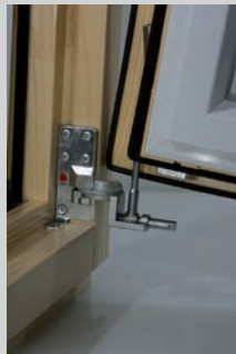
2. Flügel einhängen, Flügel in den Achsstift einführen
