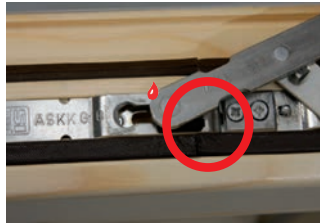
ZUSCHLAGSICHERUNG (oben) Vermeidet, daß gekipptes Fenster bei Zugluft zuschlägt
