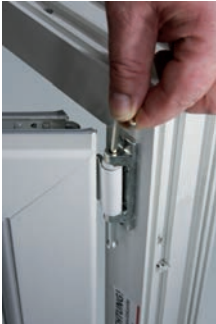
4. Scherenlager oben, Sicherungsbolzen nach unten entfernen (mit Inbusschlüssel 4 mm)
