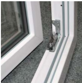
1. Griffstellung waagrecht, Flügel unten links und rechts parallel zum Rahmen einhängen. Achtung: Richtige Sitzposition vom Flügelheber beachten!
