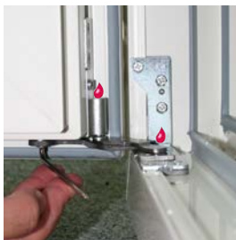
Flügelandruckeinstellung am Band unten + / - 0,7 mm (Abb. 2)
