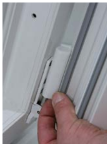
Höhenverstellung Beschlagsabdeckung entfernen
