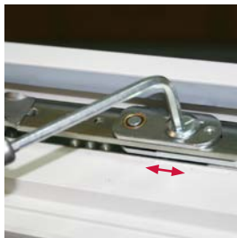
Seitenverstellung oben - 1 / + 2,5 mm (Abb. 1)
