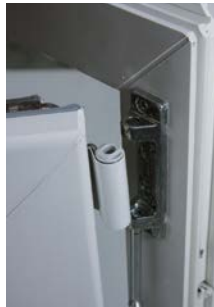
5. Fenster oben, bei Bandlenker, herausziehen
