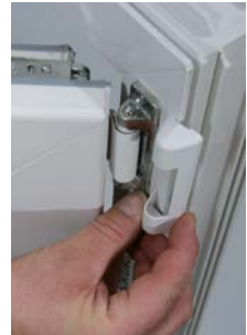
3. Beschlagsabdeckung oben entfernen
