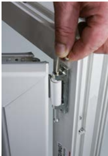
4. Scherenlager oben, Sicherungsbolzen nach unten entfernen (Inbusschlüssel 4 mm)
