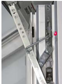
Flügelandruckeinstellung an der Schere oben + / - 1 mm
