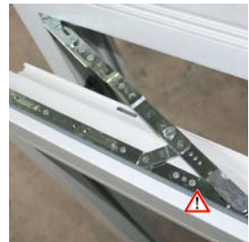
3. Fenster kippen, Scherenarm einhängen und Verriegelungshebel schließen. Achtung: Arretierfeder muss hörbar einrasten!
