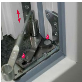
Höheneinstellung am Band unten + 2 / - 1 mm (Abb. 2)
