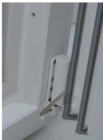
Seitenverstellung unten + / - 2 mm
