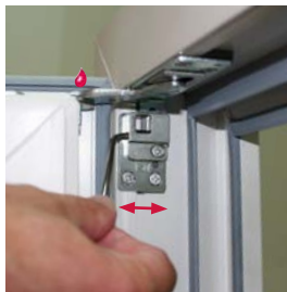
Flügelandruckeinstellung am Band oben + / - 1 mm (Abb. 1)
