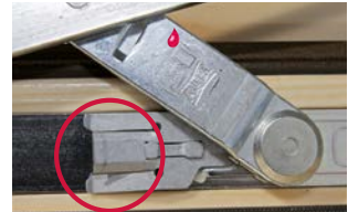
Schaltsperr e in Kippstellung oben: Verhindert Fehbedienung des gekippten Flügels
