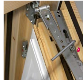
Flügelandruckeinstellung an der Schere oben + / - 1 mm
