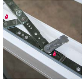
3. Verriegelungshebel vom Scherenarm auf 90° stellen
