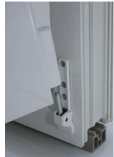
7. Flügel aus Ecklager unten heraus ziehen
