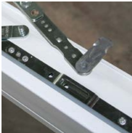
4. Scherenarm aushängen
