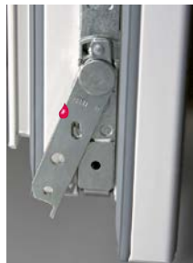
Flügelheber mit Schaltsperr e in Dreh- richtung, hebt automa- tisch beim Kippen und Schließen den Flügel an, Entlastung des Flügels
