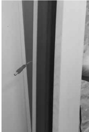
2. Stecker durch gekipptes Fenster nach außen führen
